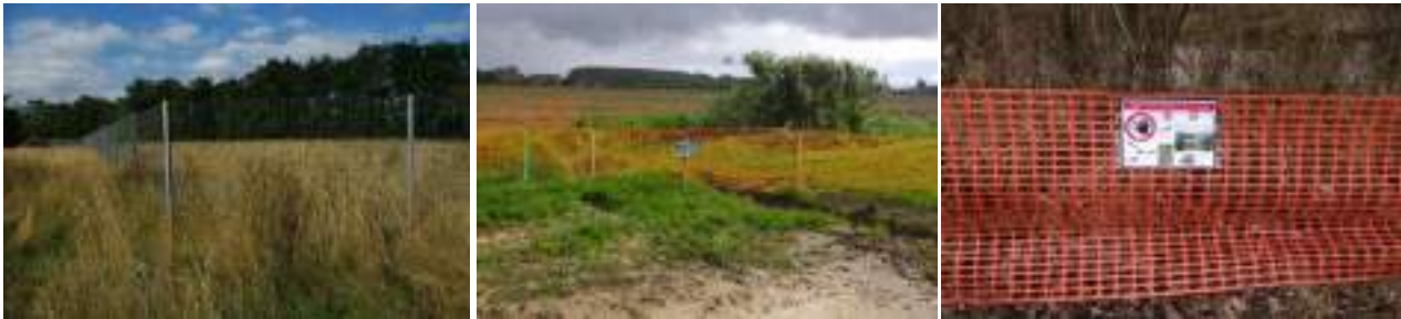
Figure 45 : dispositifs de chantier de balisage et de protection du milieu naturel
