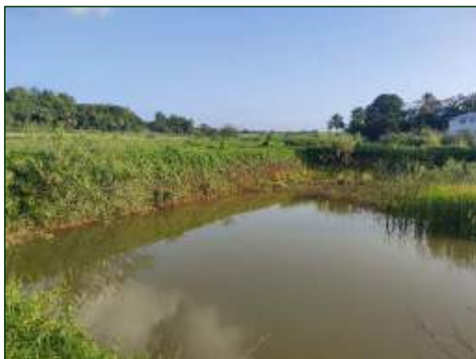
Figure 57 : Vue sur la partie en eau du réservoir
